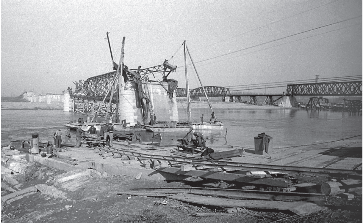
Foto 4 Nell'immagine concessa dall'Archivio Storico Foto Croce, il ponte ferroviario parzialmente ripristinato con una struttura Bailey e i lavori al ponte stradale probabilmente nell'autunno 1945
