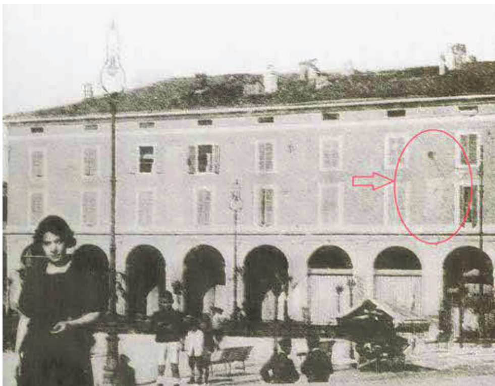
Dettaglio della cartolina pubblicata in Piacenza Una Città Nel Tempo, la freccia indica le deboli tracce della meridiana
